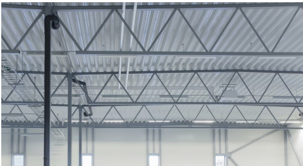
Kuva. 4.23 Esimerkki kattojärjestelmästä, jossa on kantava profiili [31]
