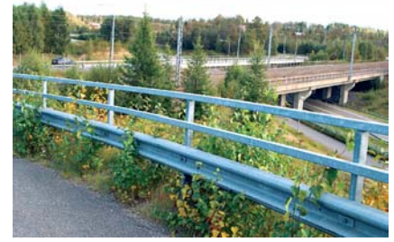
Noin 15 vuotta käytössä olleet teräsrakenteet.
