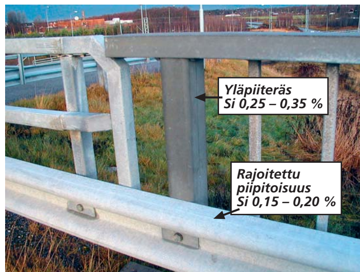
15 vuotta käytössä olleet siltarakenteet.
