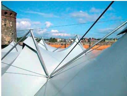
Kuumasinkittyjä kattorakenteita kulttuurirakennuksessa.
