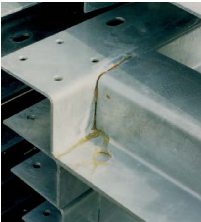
Kuva 7-11. Happopesäke, josta happo ja raudan suolat ovat syövyttäneet reiän sinkkikerrokseen aiheuttaen värvirheen.
