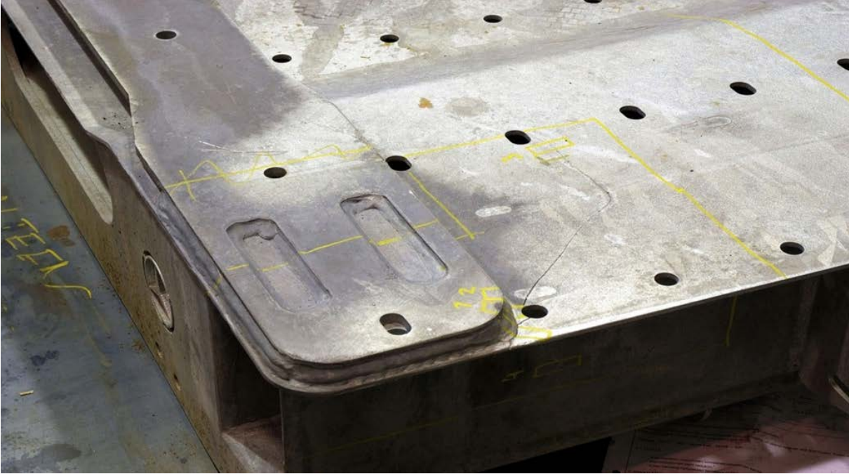
Suuren ainepaksuuseron ja hitsissä olevan särön aiheuttama halkeama
